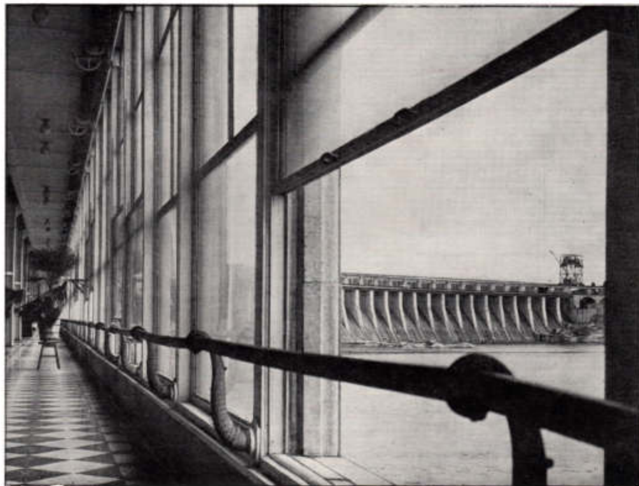
1. Видовой эркер машинного зала Днепровской ГЭС им. В. И. Ленина (архитекторы В. Веснин, Н. Колли, Г. Орлов, С. Андриевский)
